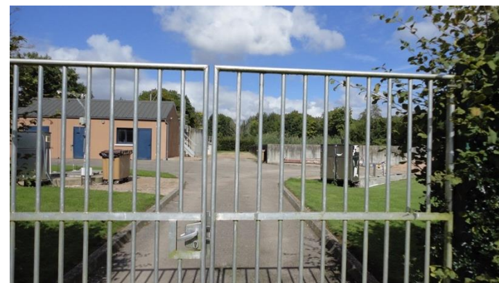
Station d'épuration de Potigny
