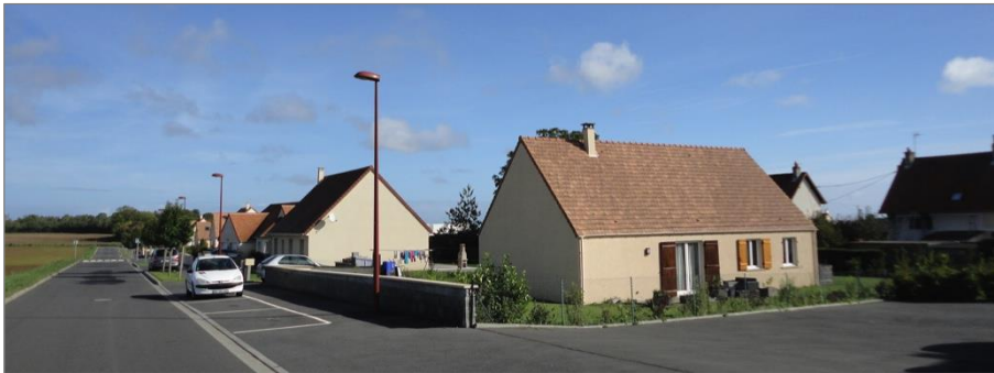
Orientation systématique des maisons par rapport à la voirie, façade Ouest, face aux vents dominants, excepté pour la maison en 1 er plan, rue du chemin Neuf
