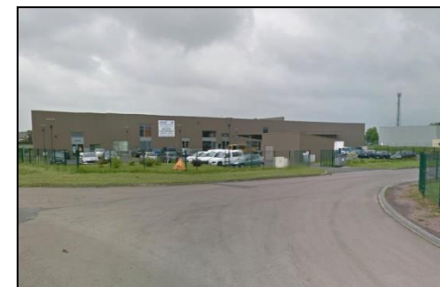
Photo 7 : Extension de la zone d'activités Rue de l'Industrie au sud-est de Falaise
