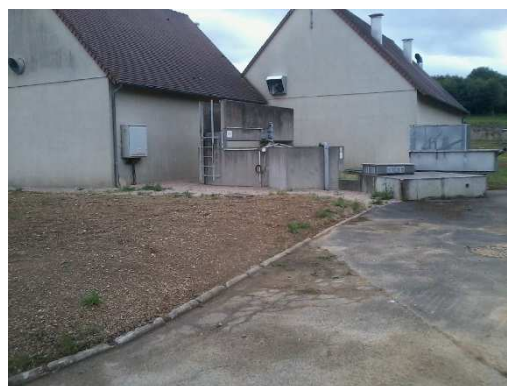
Dégraisseur et bêche à graisses
