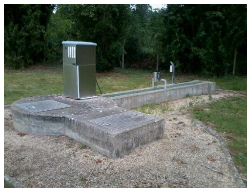
Canal de comptage aval
