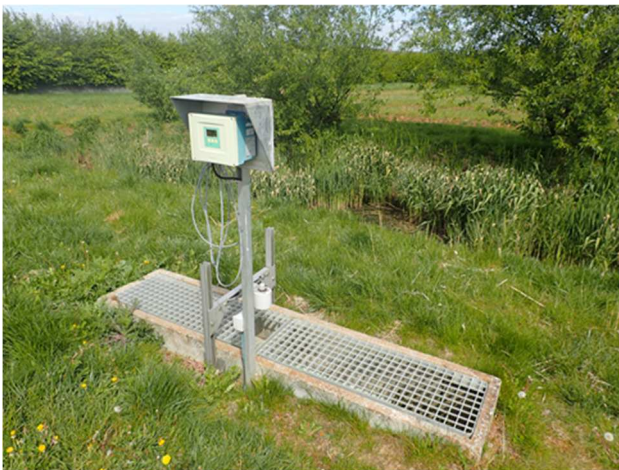
Canal de mesure en sortie
