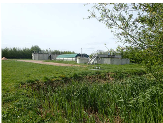
Vue générale de la station
