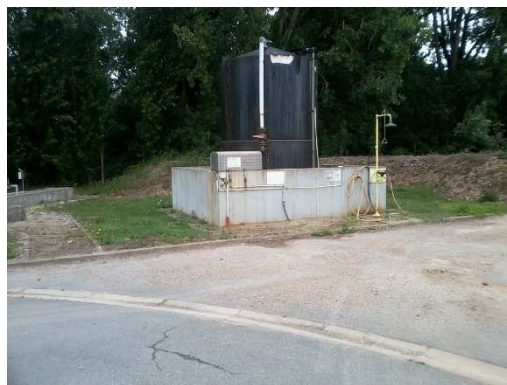
Stockage de chlorure ferrique
