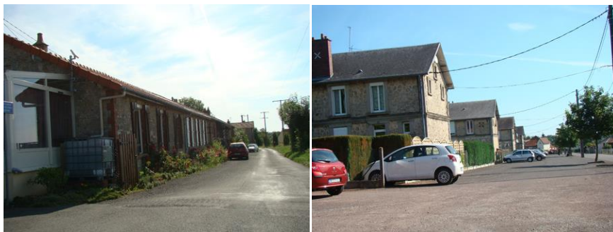
Patrimoine ouvrier à Potigny
