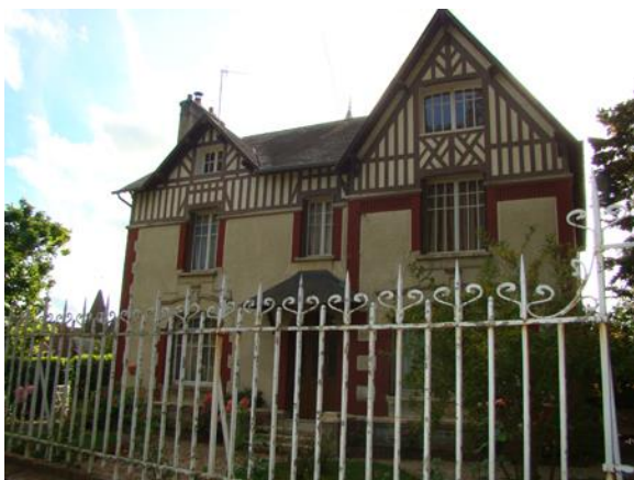
Maison de maître à Pierrepont
