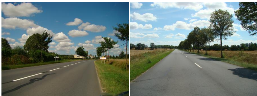
Alignements d'arbres à l'entrée de Vicques (photo 1), le long de la RD 148, qui se poursuit vers Morteaux Couliboeuf (photo 2).
