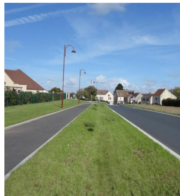
Circulation en site propre, déconnectée de la voirie par une noue, pour rejoindre le bourg au le Carrefour Contact à pied
