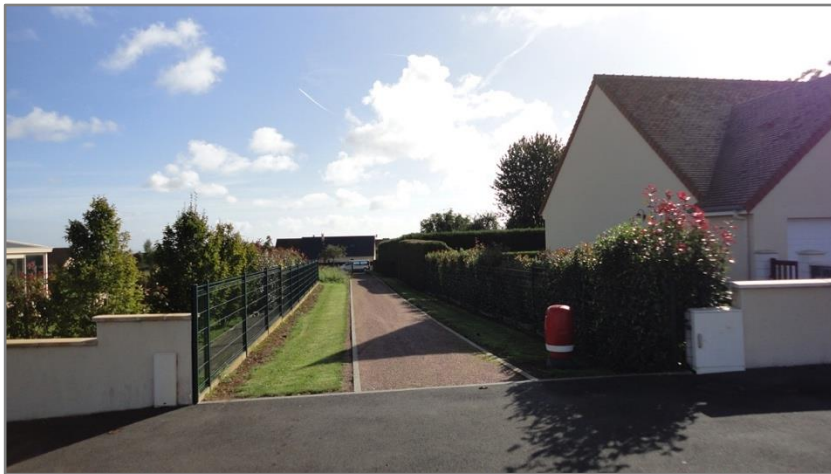
Ci-dessus et ci-dessous : Perméabilités piétonnes permettant de traverser le front bâti par des itinéraires piétons plus directs
