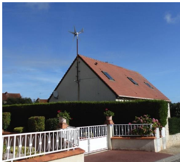
Petit éolien sur la commune de Potigny
