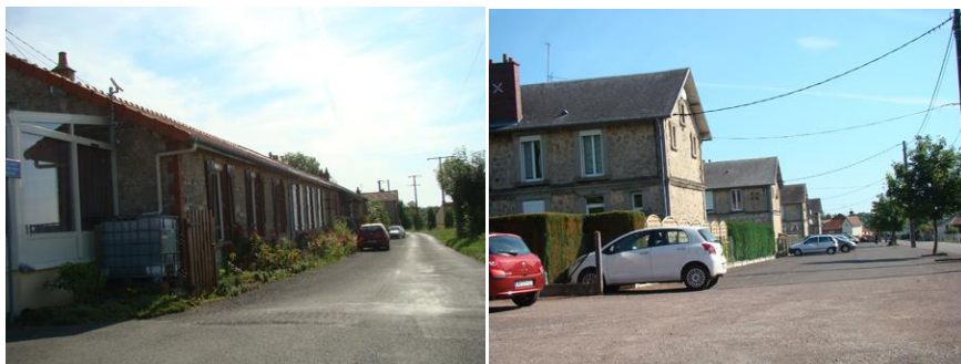
Patrimoine ouvrier à Potigny
