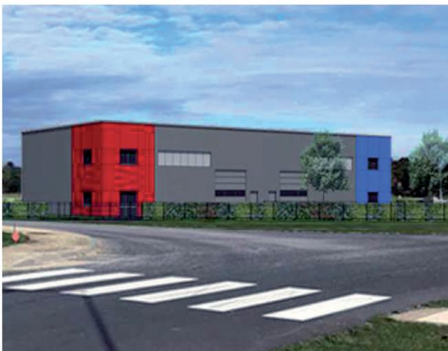
Chaque atelier fait une superficie totale de 255 m<sup>2</sup> environ dont 200 m<sup>2</sup> d'atelier et 55 m<sup>2</sup> de bureau/sanitaire. Ils disposeront également d'une mezzanine permettant de réaliser du stockage ou un agrandissement des bureaux.
