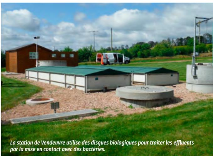
La station de Vendevre utilise des disques biologiques pour traiter les effluents par la mise en contact avec des bactéries.
