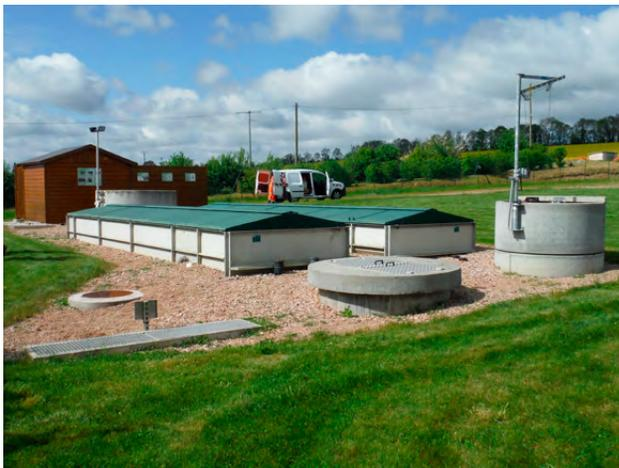
Une station utilisant des disques biologiques pour traiter les effluents par la mise en contact avec des bactéries.
